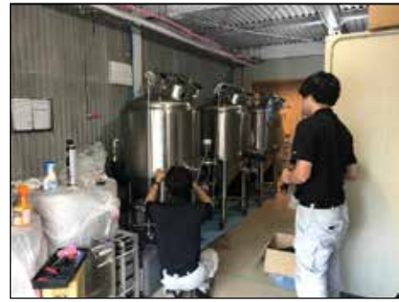
↑醸造用発酵タンクの設置状況
